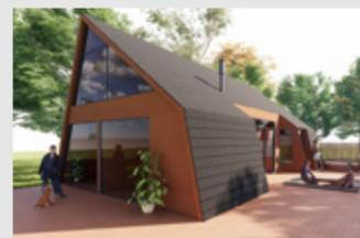
※CLTとは...直交集成材。近年各国で戸建て・共同住宅・福祉施設の居住部分に多く用いられています。断熱性・遮炎性・遮音性に優れ、壁式工法にて施工の為、耐震性も期待できます。工場にてのパネル生産の為、安定的な品質が確保されます。
