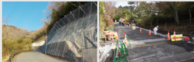
【上段】道路舗装工事【下段右】側溝改修工事【下段左】擁壁補強工事(竣工済)
