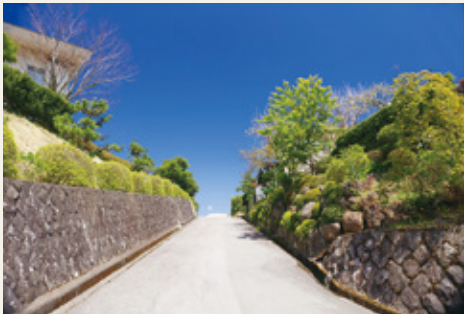
▲自主規制によって環境が守られた街並み
